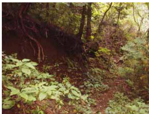
図 2 図 1 の上部、崩壊する作業道斜面。谷筋への残材の崩落を防止するためには、この抜本的対策が必要。2006 年度中に対策をたてる。
