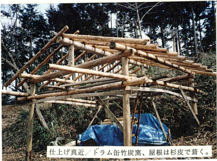
仕上げ真近／ドラム缶竹炭窯、屋根は杉皮で葺く。
