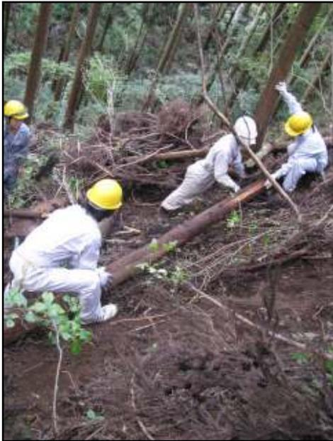
10月に入り、だいぶ涼しくなってきました。今回の活動では、午前中から午後にかけて土留めの作業を行いました。土留めは、雨が降った時に土が流されて土砂崩れなどが起きないように、間伐してある木などを水の流れる方向と垂直になるように等高線にそって配置することです。こうすることで、水の流れを抑え、土が流れてしまったり、無造作に置いてある木などが流れてしまうのを防ぎます。
